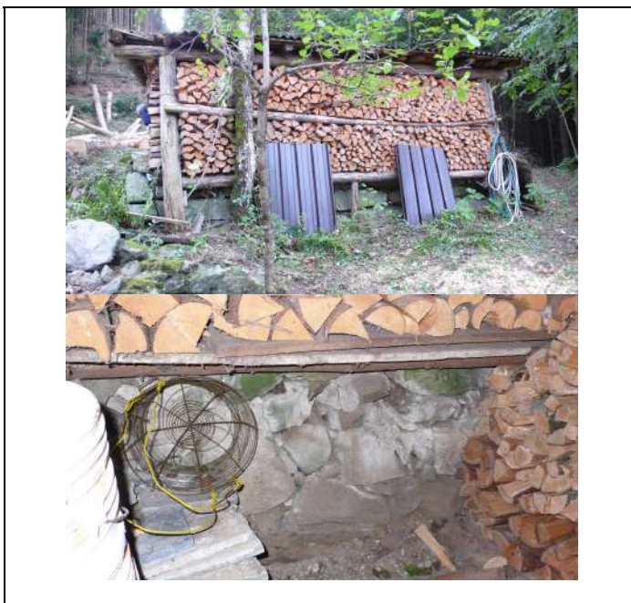
Foto 3: Legnaia posizionata al di sotto del nuovo impianto di arroccamento sulla p.f. 1825
